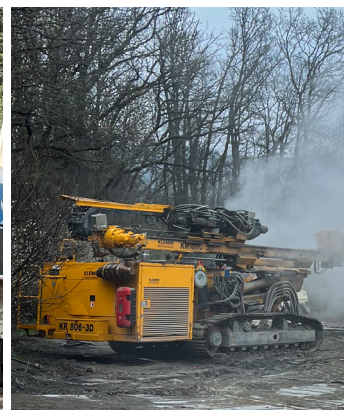
Hierbei werden diese Rohre in verschiedenen Winkeln in den Felsen eingebohrt. Nach der Bohrung wird dann mittels dieser Maschine Flüssigbeton über die Rohre in den Felsen eingespritzt, um das vorhandene Schiefergeröll zu festigen.
