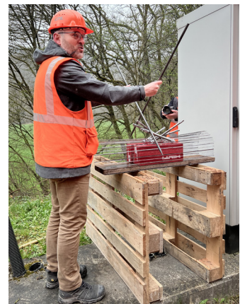
André Feltz (II) erklärt die komplexen Stabilisierungs- und Befestigungsarbeiten anhand eines Modells
