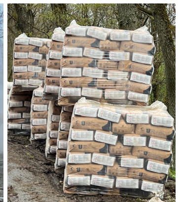
Bis zum 20. April 2023 wurden etwa 350 Kubikmeter Beton in den Felsen injiziert.
