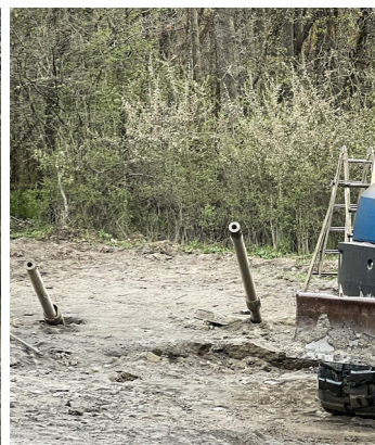
Hierbei werden diese Rohre in verschiedenen Winkeln in den Felsen eingebohrt. Nach der Bohrung wird dann mittels dieser Maschine Flüssigbeton über die Rohre in den Felsen eingespritzt, um das vorhandene Schiefergeröll zu festigen.
